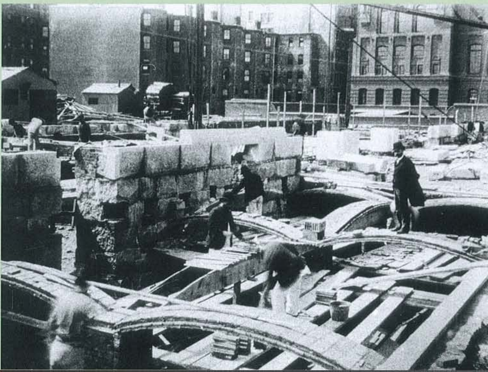
19 CONSTRUCCIÓN DE ARCOS TABICADOS EN LA BIBLIOTECA DE BOSTON. EL HOMBRE DE PIE SOBRE UNO DE LOS ARCOS ES RAFAEL GUASTAVINO
